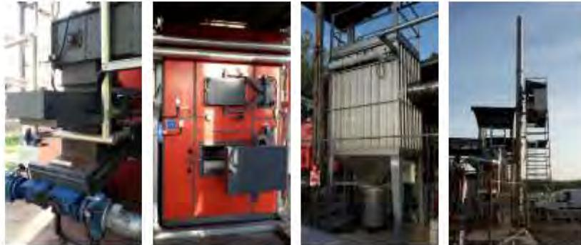
**Figura 2:** da sinistra a destra sistema di alimentazione della biomassa, forno a griglia mobile, filtro a maniche e camino.
